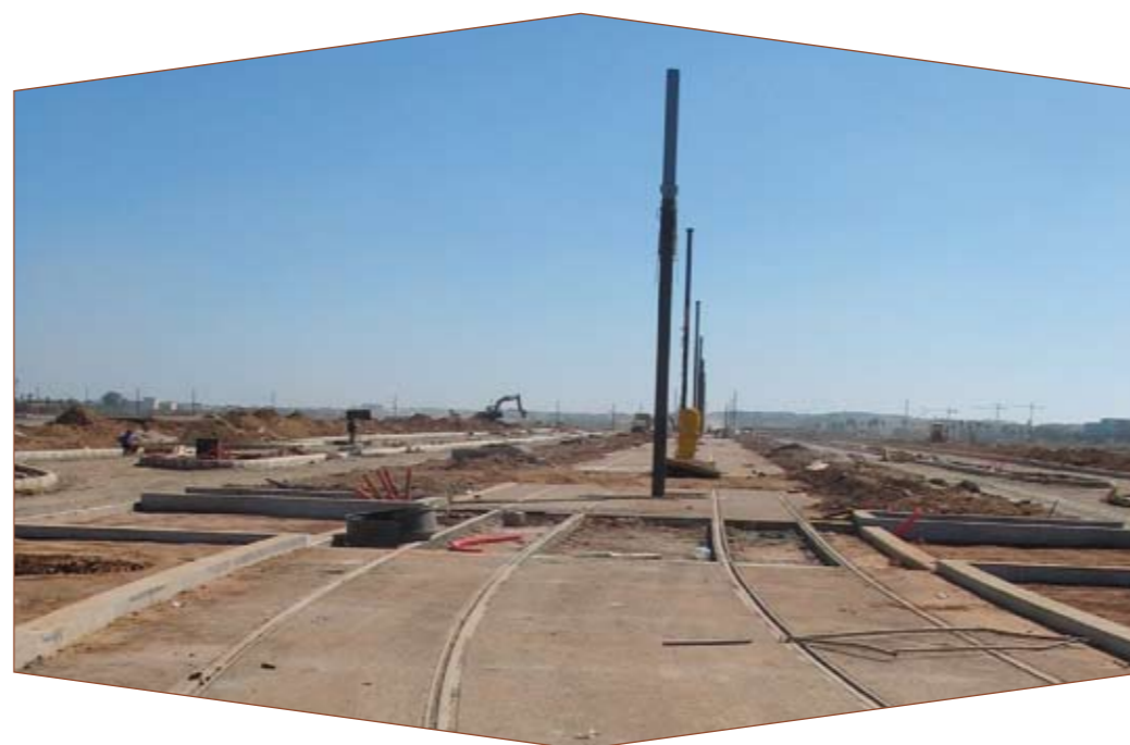
Le tracé du tramway de Casablanca du côté nord du projet Anfa Park.
